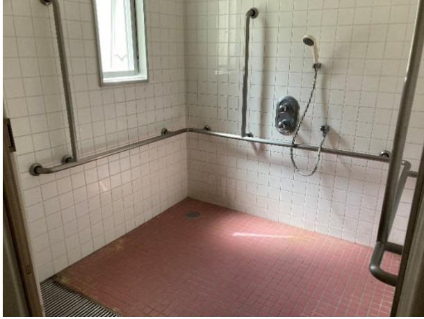
体育館 車いす用シャワー室
