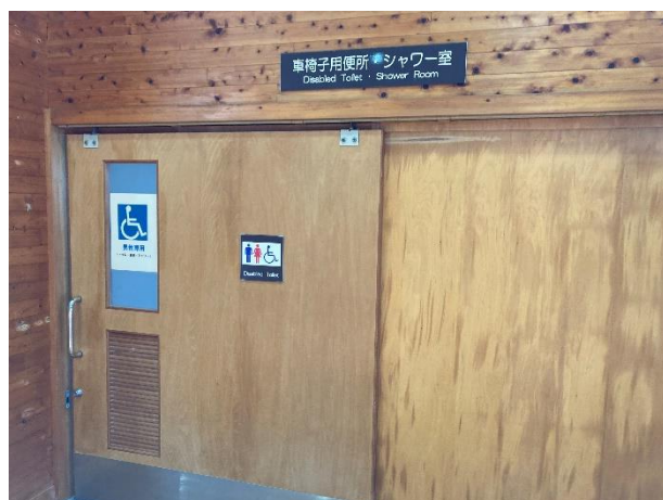
体育館 車いす用シャワー室
